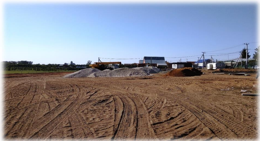
Подготовительные работы для укладки асфальта
