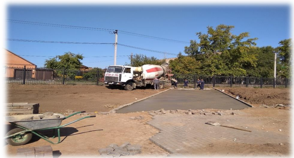
Укладка тротуарной плитки
