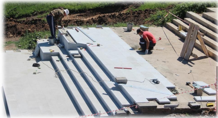
Монтаж гранитных плит лестницы
