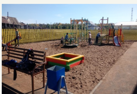
Благоустройство детской площадки с.Николаевка
