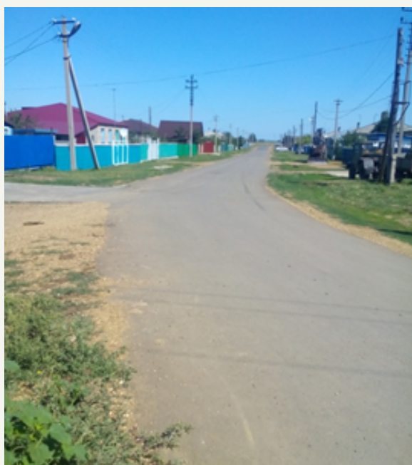
Ремонт дороги п.Суворовский Тоцкий район
