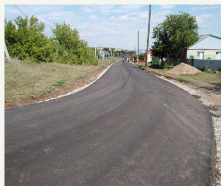
Ремонт дороги с.Романовка
